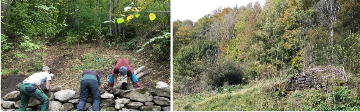
Das richtige Bauen einer Trockenmauer will gelernt sein und bedarf viel Muskelkraft. NL
